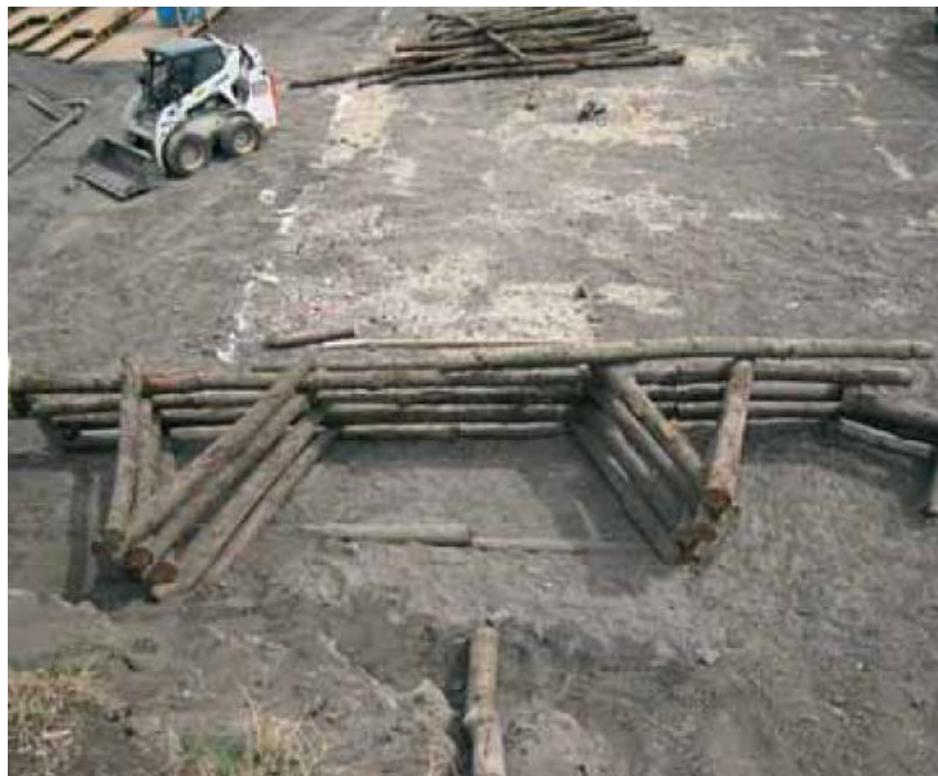
Figura 34: Entramado tipo Latino, ubicación de los troncos. Fuente: Cornellini, 2007.
