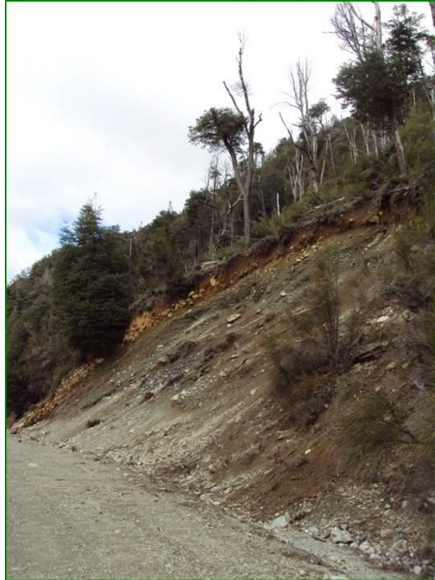
Figura 1: Talud en Ruta 40 Sur. Fuente: Imagen propia.
