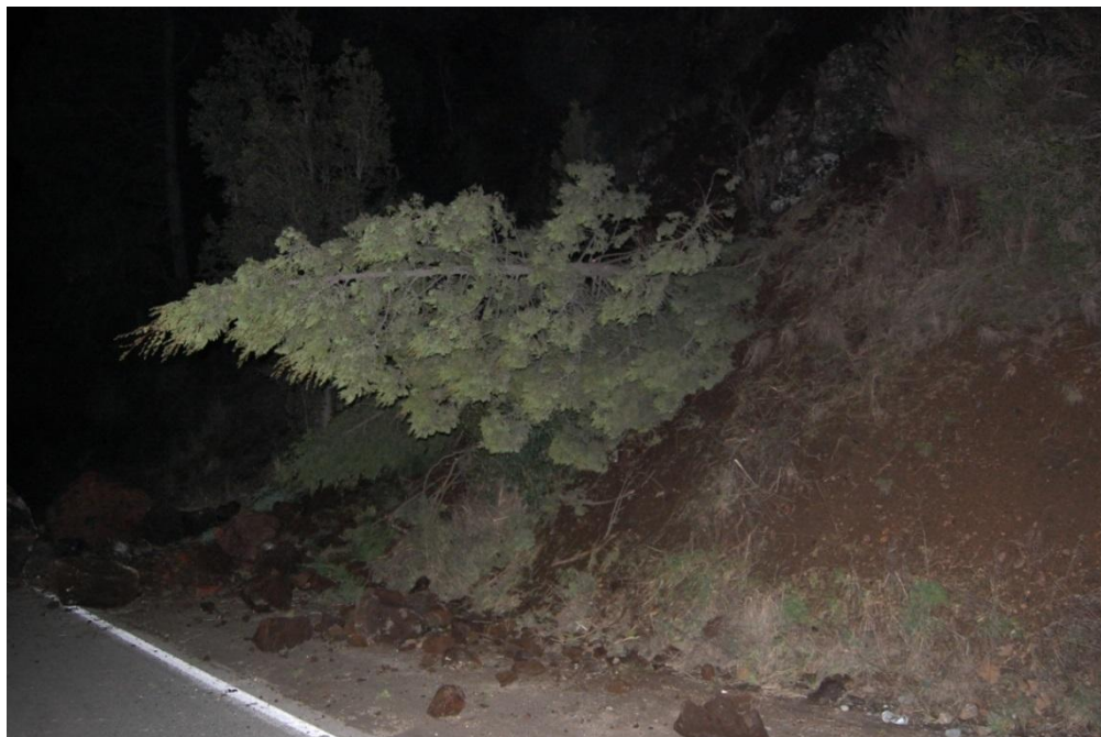
Figura 10: Caída de árbol en km 12 de Bustillo en septiembre de 2015. Fuente: Imagen Subsecretaría de Medio Ambiente Bariloche.
