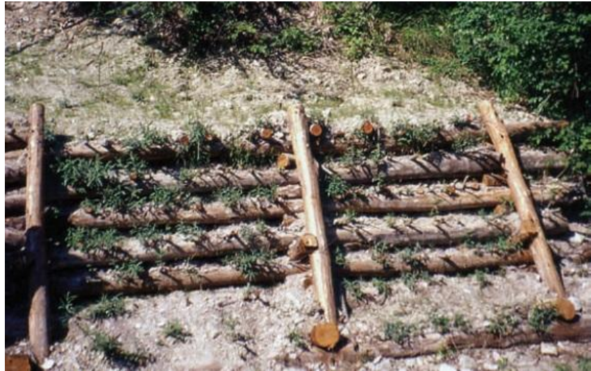
Figura 33: Entramado tipo Roma, finalizado. Fuente: Zeh, 2007
