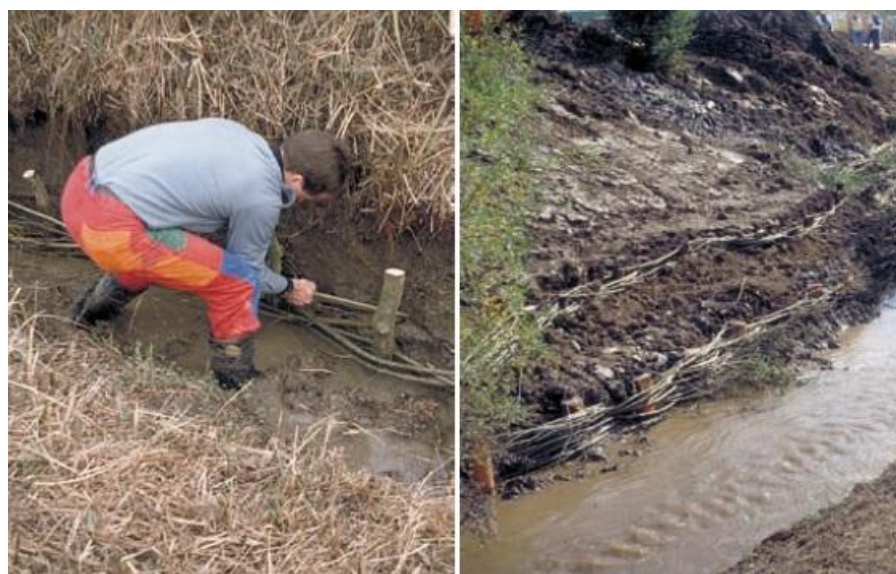
Figura 28: Empalizada trenzada. Fuente: Zeh, 2007
