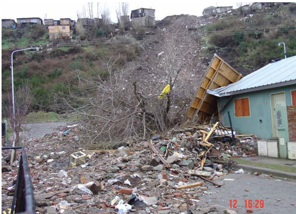
Figura 7: Otra vista, en este caso desde abajo del deslizamiento ocurrido en el año 2004 que afectó viviendas ubicadas al pie de la Barda del Ñireco. Fuente: SEGEMAR, 2005.
