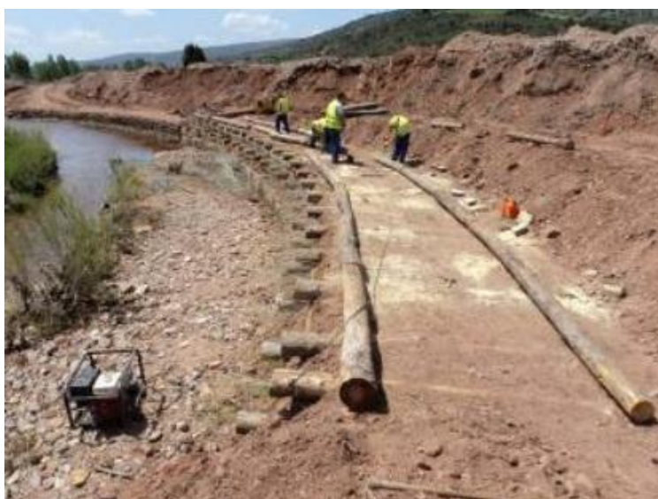
Figura 30: Muro Krainer, operarios. Fuente: Sánchez et al. (2013)
