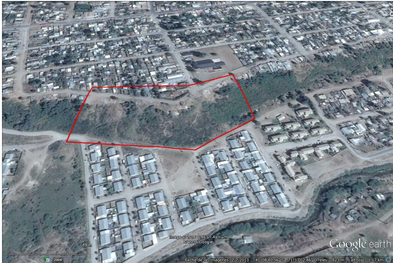
Figura 80: Talud B_03, luego del incendio. Fuente: Google Earth
