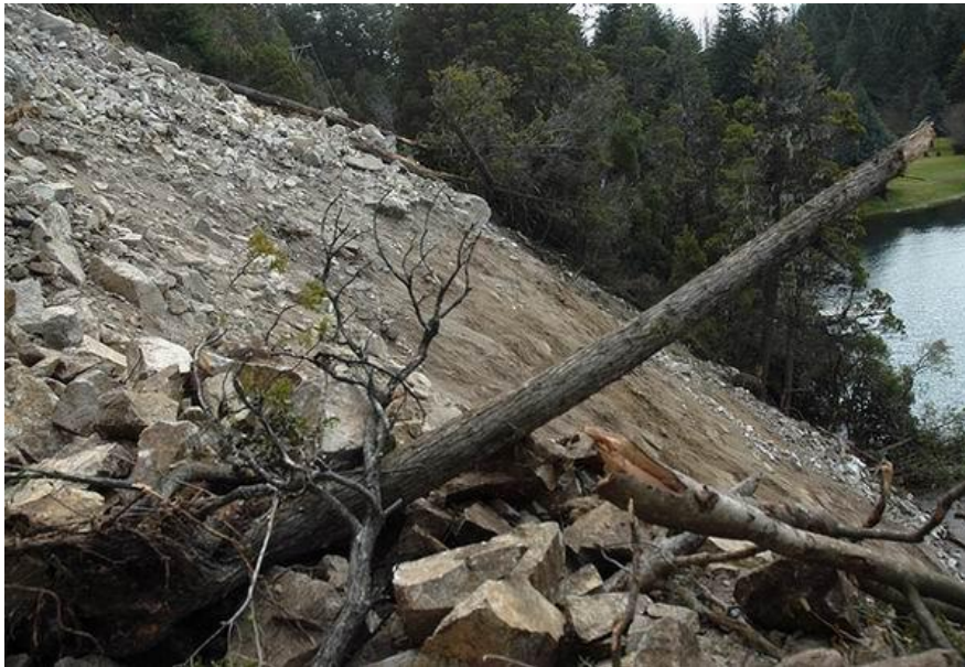
Figura 8: Derrumbe en Colonia Suiza, 2009. Fuente: Imagen Bariloche2000.
