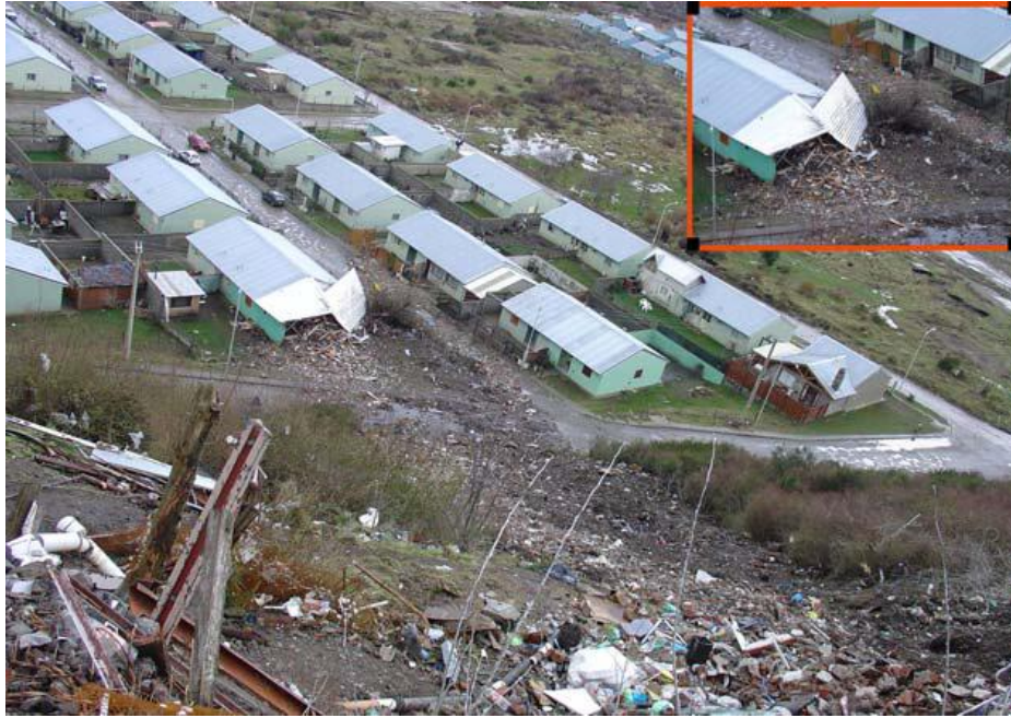
Figura 6: Deslizamiento ocurrido en el año 2004 que afectó viviendas ubicadas al pie de la Barda del Ñireco. Fuente: SEGEMAR, 2005.
