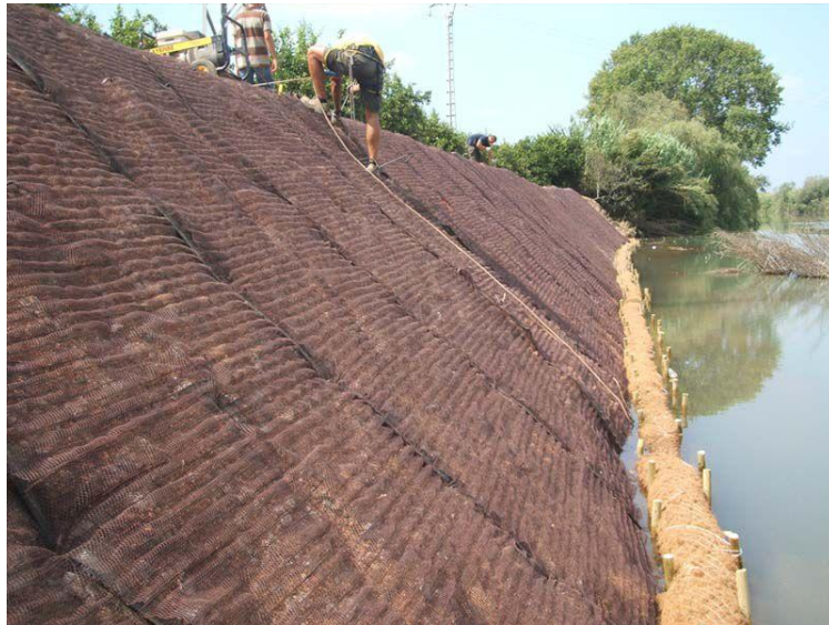
Figura 20: Geomalla tridimensional. Fuente: projar.es
