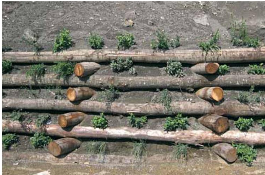
Figura 35: Entramado tipo Latino, terminado. Fuente: Cornelini, 2007.
