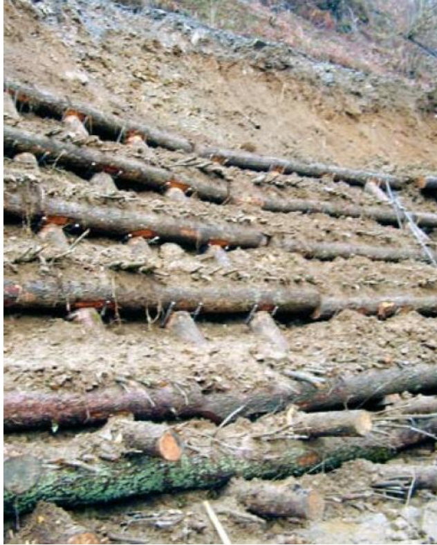
Figura 38: Muro Krainer terminado. Fuente: Sangalli&Lizarralde, 2005.
