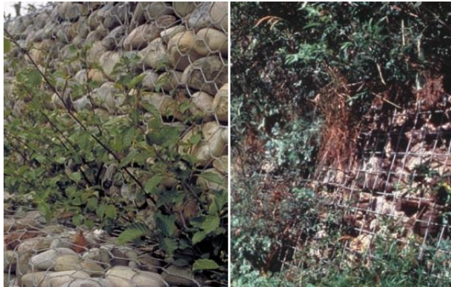
Figura 37: Gaviones revegetados. Fuente: Zeh, 2007.
