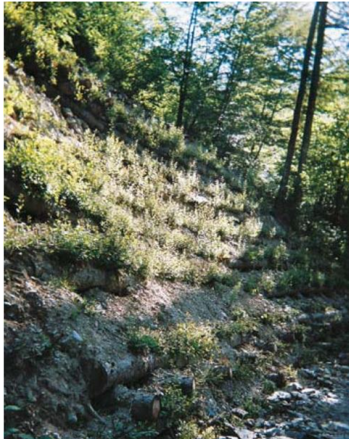
Figura 39: Muro Krainer con vegetación desarrollada. Fuente: Sangalli&Lizarralde, 2005.
