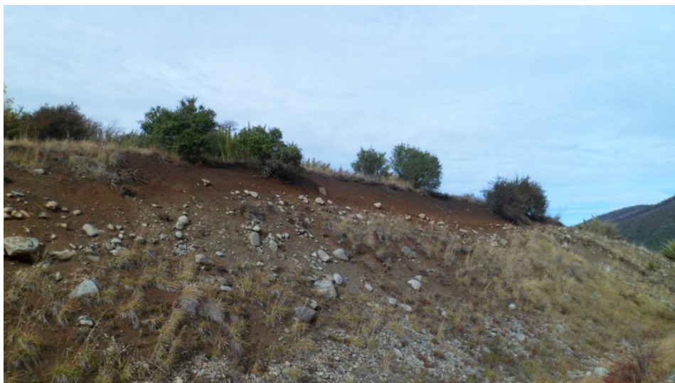
Figura 2: Talud en Ruta 40 Sur. Fuente: Imagen propia.
