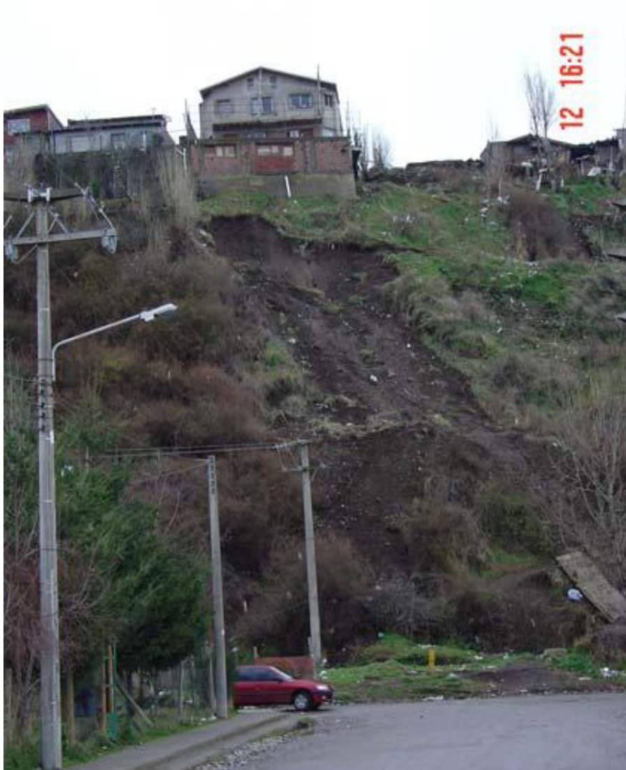
Figura 5: Deslizamiento ocurrido en la Barda del Ñireco. Fuente: SEGEMAR, 2005.
