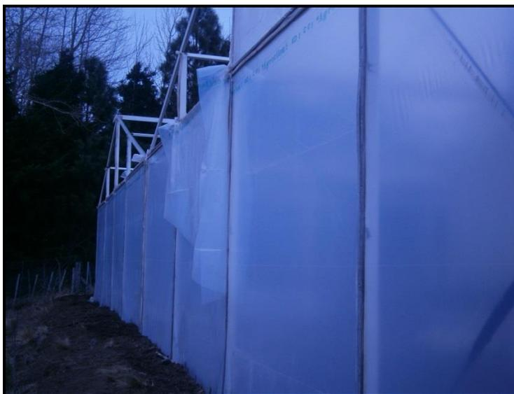
**Figura 49: colocación polietileno en perímetro.**
