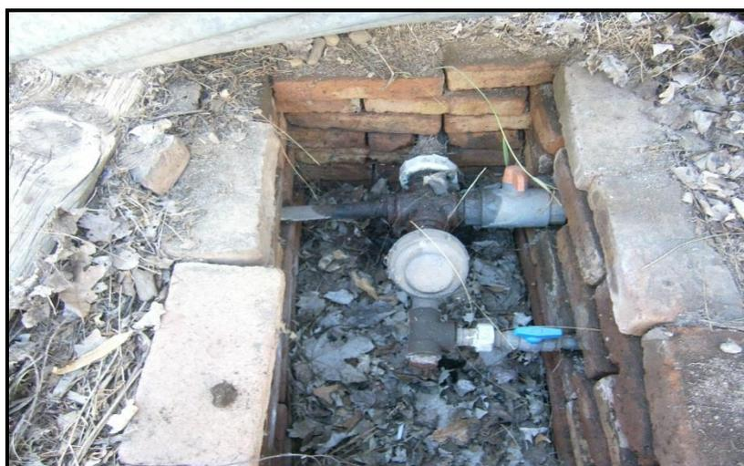
Figura 37: detalle de filtro de anillas.
