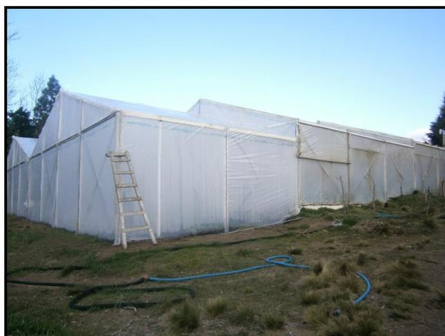
**Figura 51: polietileno colocado.**
