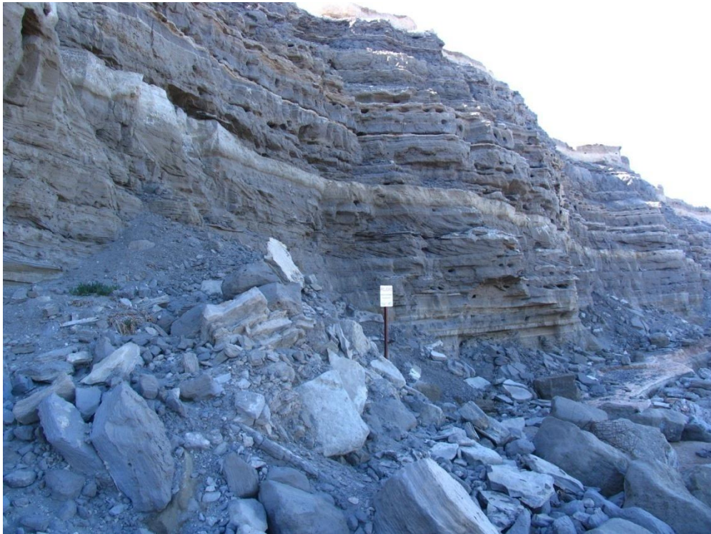
Figura 6.3: Fotografía al pie del acantilado que permite apreciar los bloques caídos desde el mismo.
