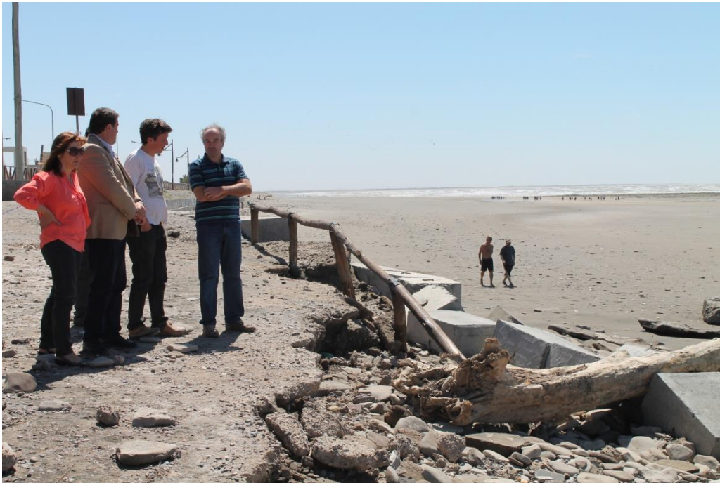
Figura 1.1: Fotografía tomada después de ambos eventos de sudestada, donde se puede advertir como el oleaje destruyó la defensa costera.
