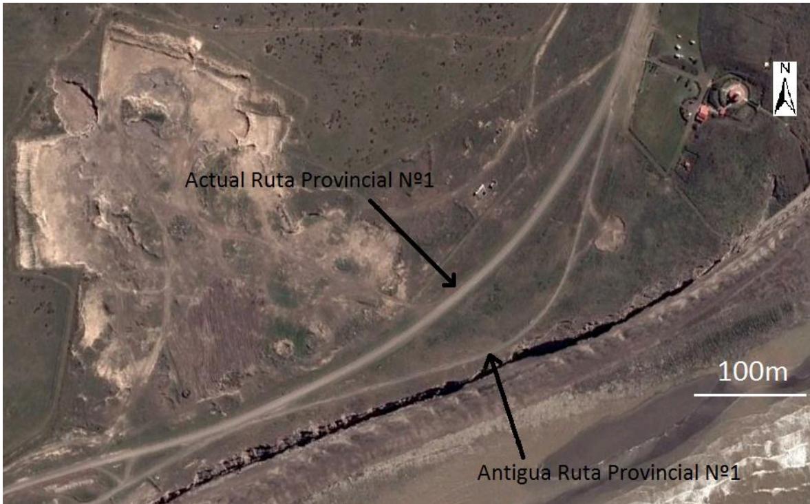
Figura 11.2: Imagen satelital donde se evidencia el cambio forzoso de la Ruta Provincial N°1 a causa del retroceso costero.
