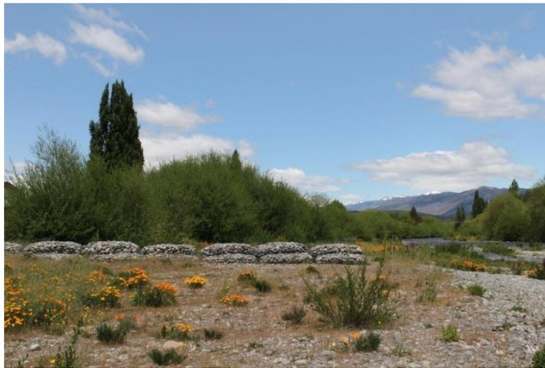
**Figura 3.35.** Espigón de un metro de alto sobre la ribera izquierda del río.
