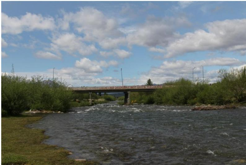
**Figura 3.34.** Puente que conecta ambas orillas del río en el cual se observa acumulación de sedimentos sobre sus pilares.
