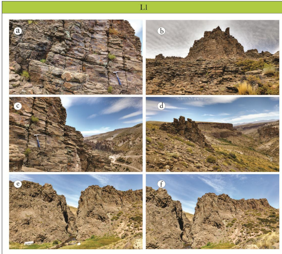
Figura 14: a-, b-, c- y d- Vista panorámica donde se puede observar el afloramiento de las facies ( L1) sobre las márgenes del Arroyo Covunco; b y f Afloramiento de las facies (L1) en Cajón del Atreuco.
