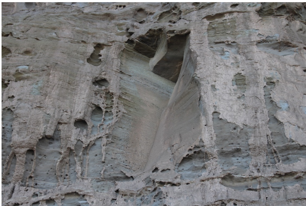
Figura 4.7. Vista del frente del acantilado en la que se aprecia rotura en cuña por la conjunción de dos planos de diaclasas.
