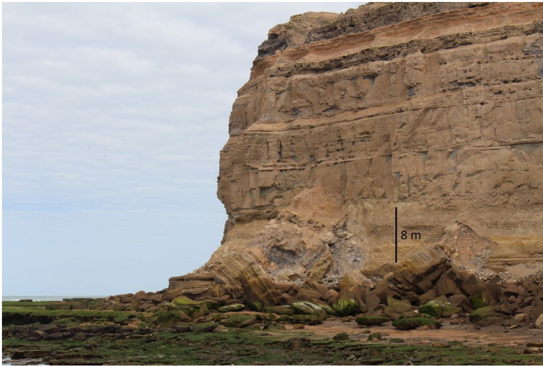
Figura. 4.12. Deslizamientos conformando talud de detritos, apoyados sobre plataforma de abrasión y playa.
