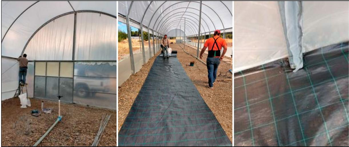
Figura 45: Colocación de riendas y geo-textil en invernadero n°4.
