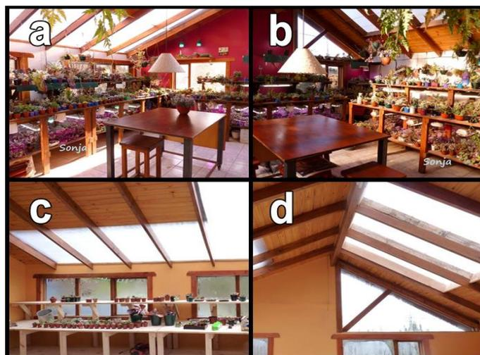
Figura 4. a), b) Mesadas con plantas madre y bandejas con plantas para engorde en Invernadero 2. c), d) Estructura de madera y techo con policarbonato de Invernadero 2
