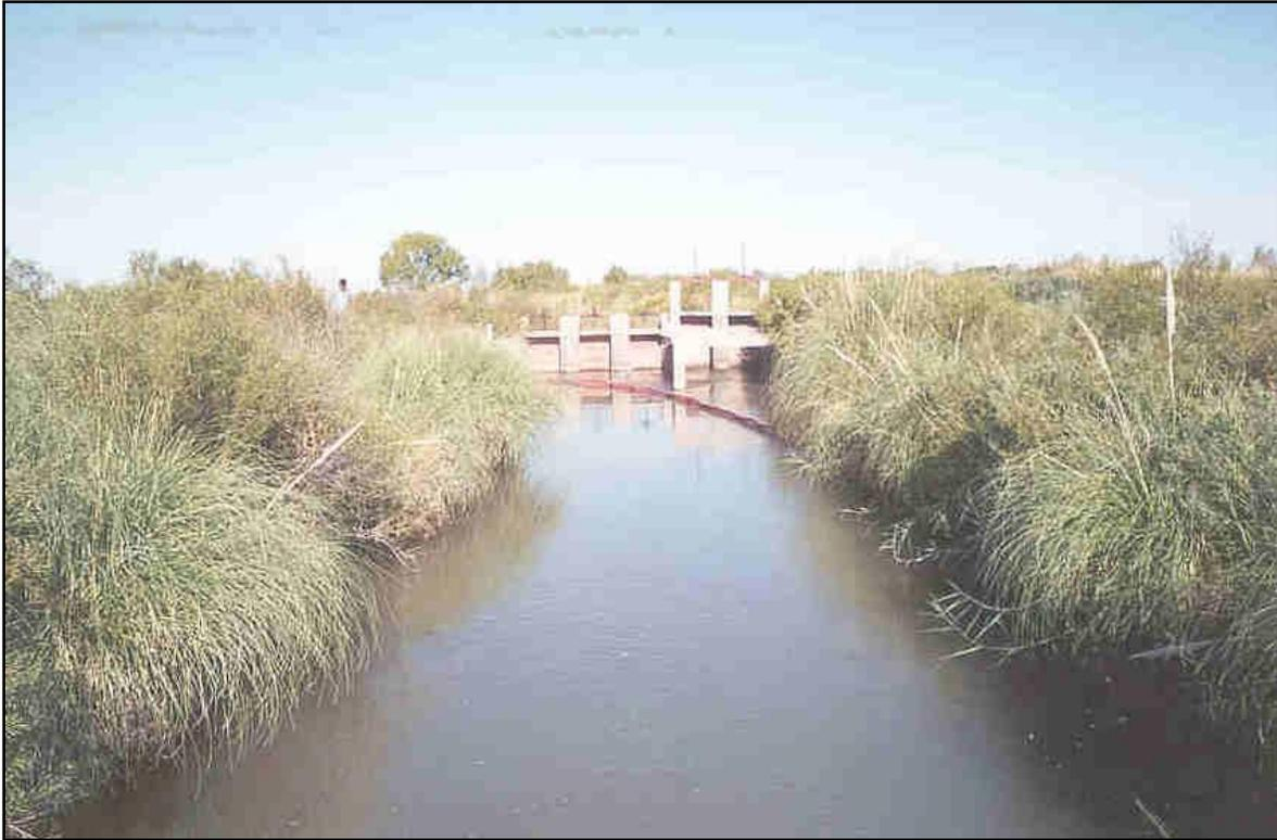
*Figura 4.4 Obra de toma y brazo aductor del Sistema de Riego Peñas Blancas.*
