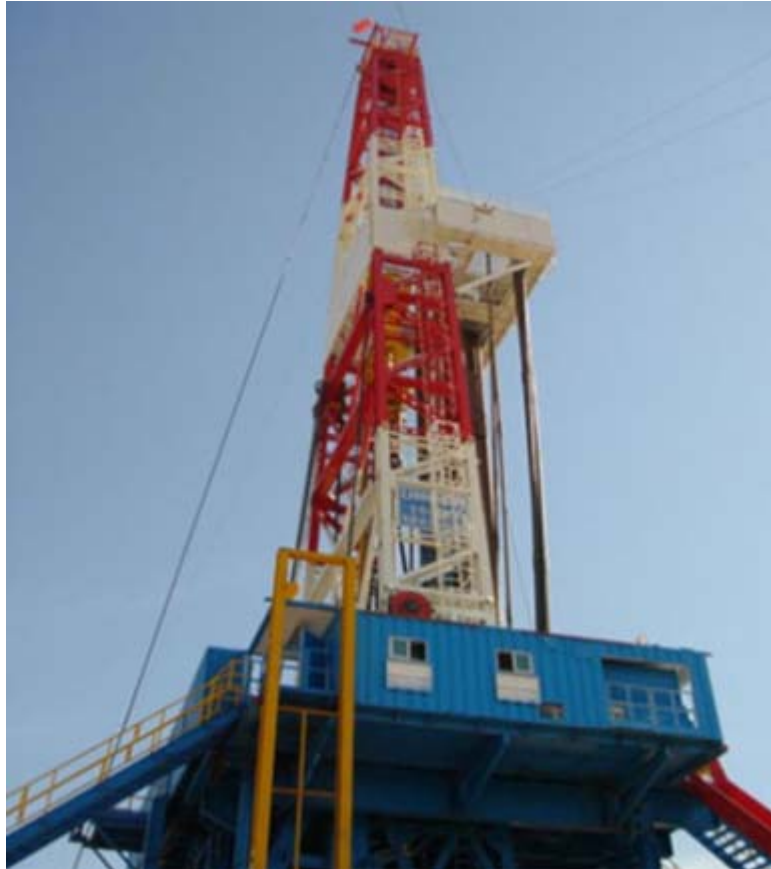
Figura N° 35. Torre de perforación 10
