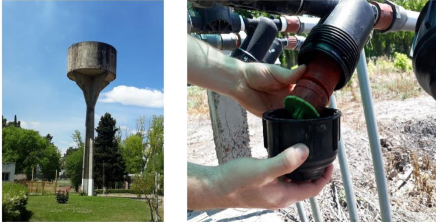
Figura 12. Tanque elevado y sistema de filtrado de impurezas. Fuente: elaboración propia
