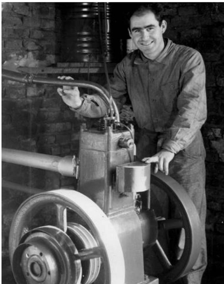
**Figura 23. Augusto Cicaré junto a un motor diésel de solamente tres piezas móviles diseñado y construido en su juventud para accionar un generador eléctrico (1960).**
