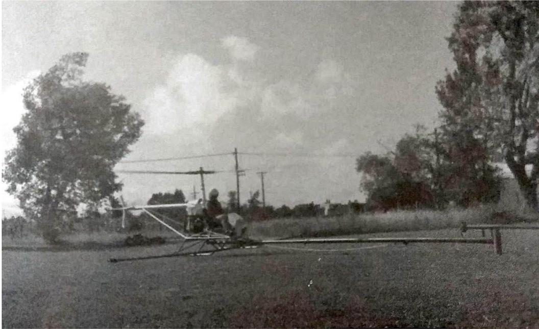
**Figura 34. Prototipo CH-2 al mando de Augusto Cicaré en el banco de pruebas de barra metálica anclada al piso (1996).**
