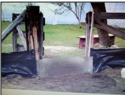
Barrera de acceso al predio
