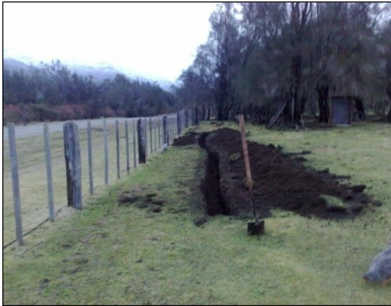
Zanja de protección
