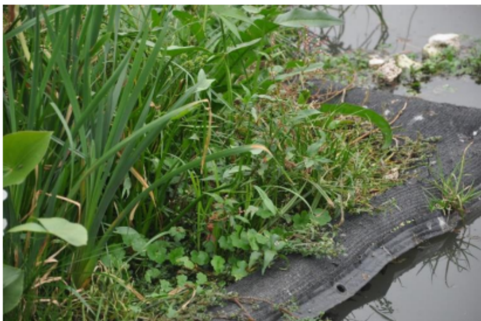
Figura 4.2.9: Diseño de la superficie flotante con tubos de PVC, malla textil y alambre. Fuente: Escuela de Comercio N° 35, 2016. Expide: Autoridad de Cuenca Matanza Riachuelo (Acumar).
