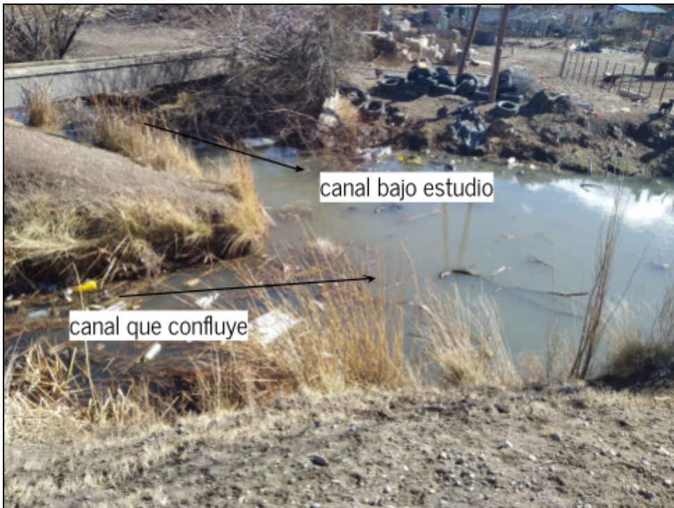
Figura 4.1.2.19: Confluencia del canal bajo estudio y otro canal. Fuente: propia.
