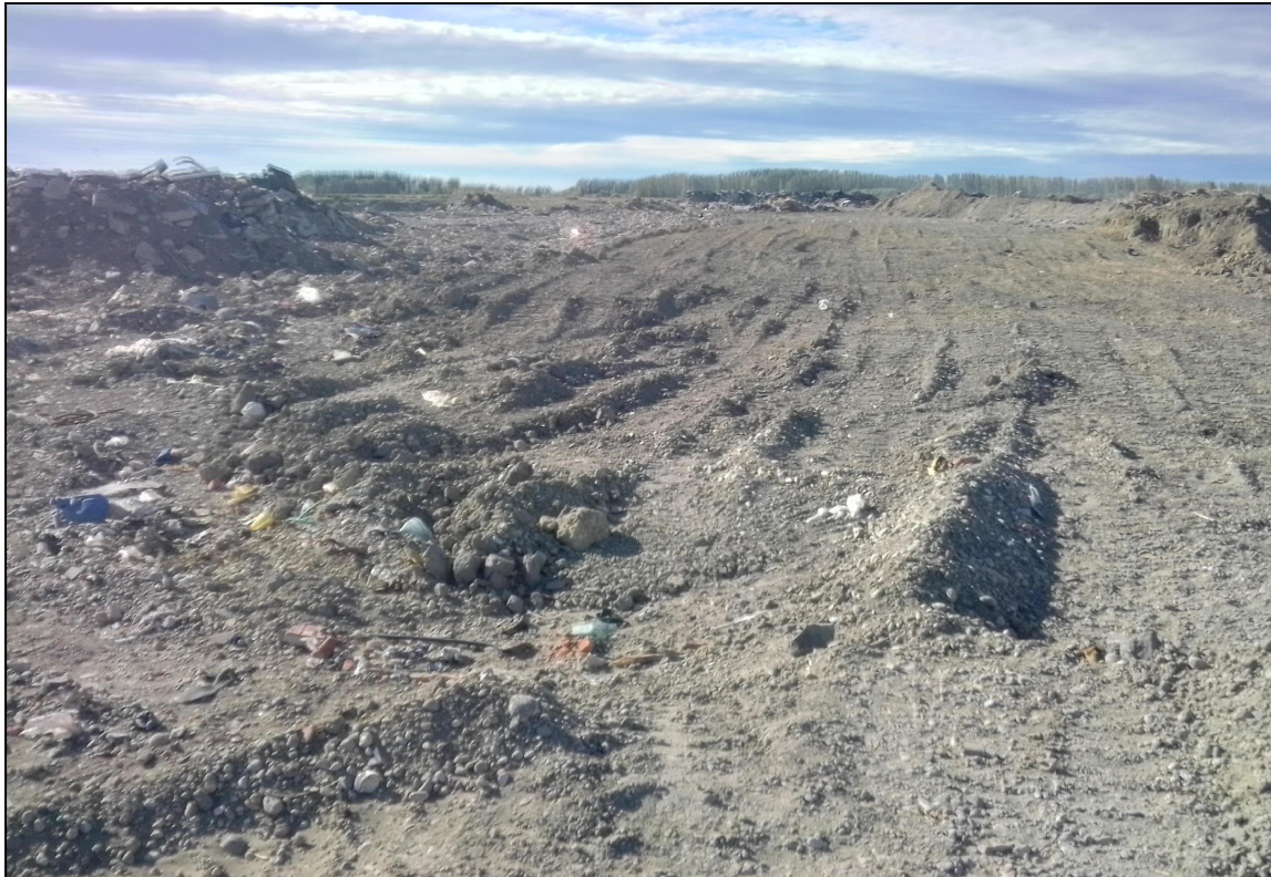
Figura 4.1.1.10: Suelo post enterramiento de residuos que se extiende en dirección este. Por debajo del nivel topográfico se hallan residuos depositados y cubiertos. Fuente: propia. Fecha de captura: 23/03/21.
