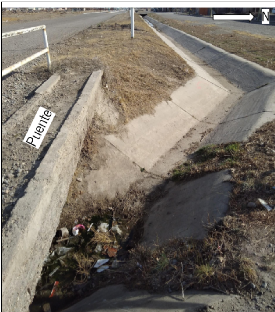
Figura 4.1.2.15: "Colector 2" hacia el oeste del puente que divide el colector en permanente e intermitente. Se presenta seco cuando no hay precipitaciones. Fuente: propia. Fecha de captura: 14/08/21.
