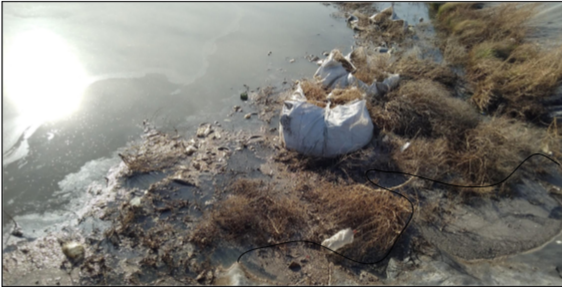
Figura 4.1.7.4: Plantas desarrolladas y/o arrastradas por acción del viento en el margen izquierdo de la laguna primaria N°1 y película de grasa . Fuente: propia.
