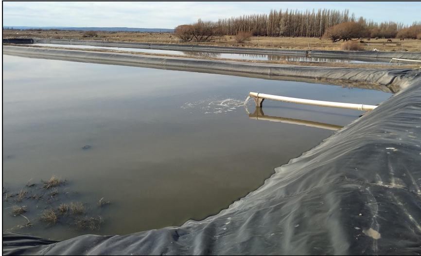
Figura 4.1.7.8: Plantas desarrolladas en la laguna N° 2.1. Se observa una imagen similar en las restantes lagunas. Fuente: propia.
