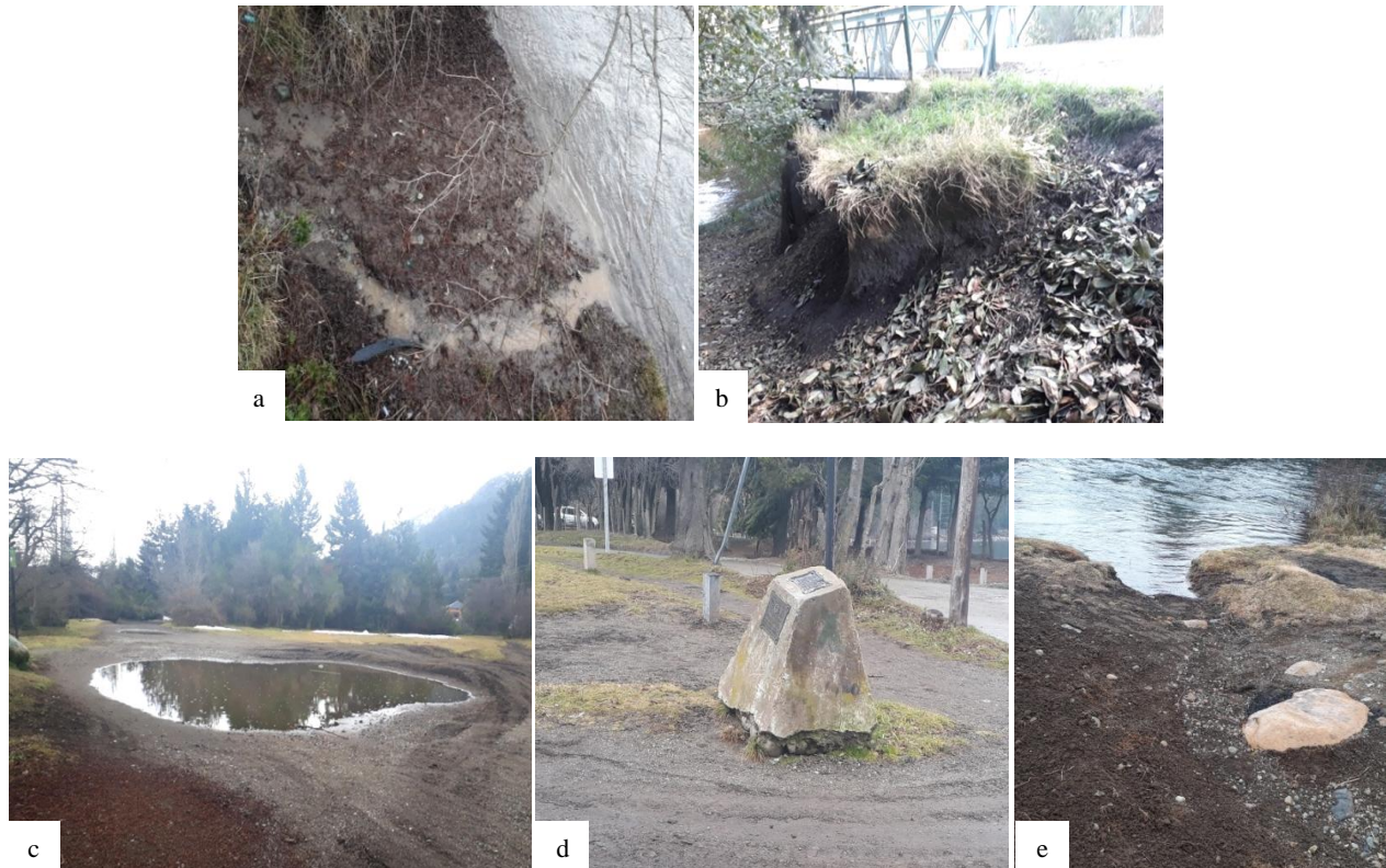
Figura 16: Estructuras erosivas identificadas en: a) Sitio I izquierda se observa un surco formado por el escurrimiento de agua superficial, b) Sitio I izquierda cárcava en cercanías de puente peatonal, c) Sitio I derecho sector de anegamiento, d) Sitio I derecho, evidencia de erosión laminar en la base de una estructura rígida, e) Sitio II izquierda, afloramientos rocosos por erosión laminar.
