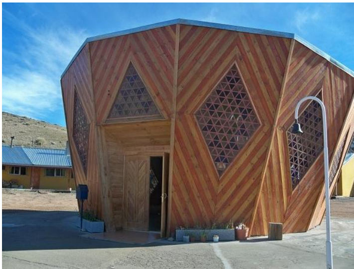
Figura 5: exterior e interior de la capilla donde se encuentran los restos de Ceferino Namuncurá
