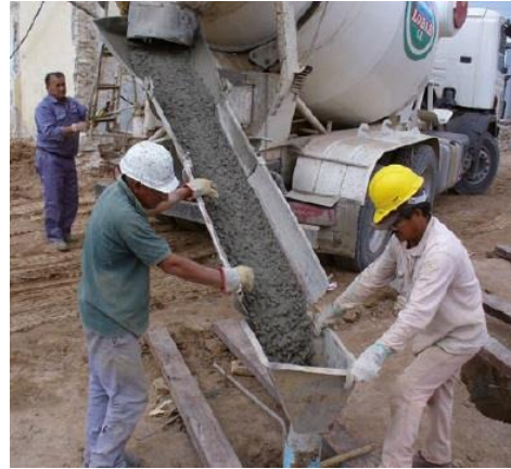
Imagen: Descarga del hormigón por canaleta del mixer.
