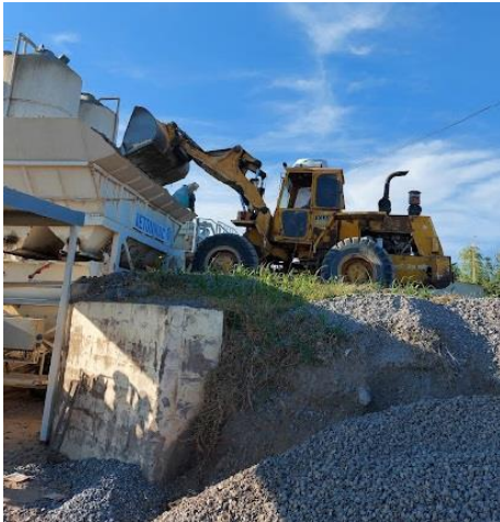
Imagen: Carga de tolvas con pala cargadora.
