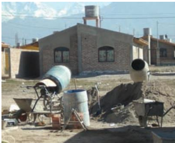
Imagen: Hormigón en obra (in-situ)
