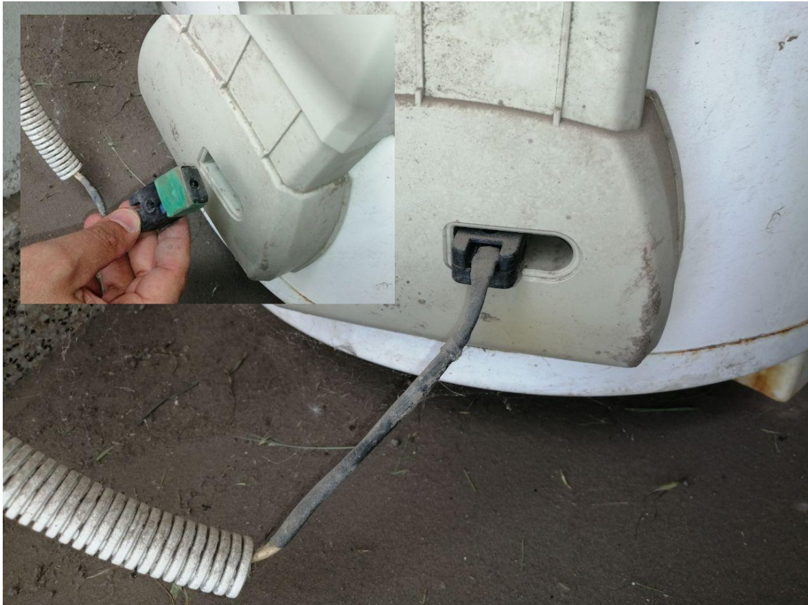
Fig. 10. Ubicación de la instalación del sensor de flama. Elaboración propia.
