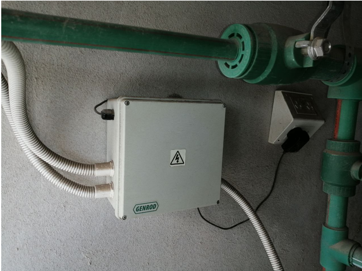
Fig. 7. Caja estanca que resguarda la Raspberry Pi junto a todos los terminales de conexión de los sensores. Elaboración propia.
