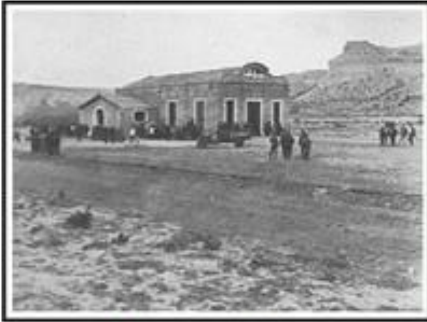
Edificio FAI - Abril de 1927
