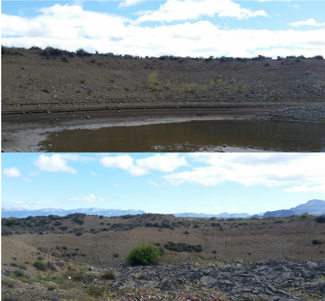
Figura 45 – Taludes en el norte de la cantera. Fuente: elaboración propia.
