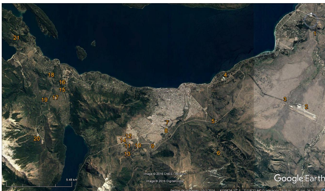
Figura 15– Ubicación de las canteras identificadas dentro del ejido de S.C. de Bariloche y alrededores. Los números indican cada una de las canteras: 1) Áridos del Ñirihuau, 2) Aeropuerto, 3) Ruta Prov. N°80, 4) Ñire (Planta de beneficio), 5) Estación transformadora, 6) Áridos Arroyo del Medio, 7) Municipal, 8) Ñire, 9) Codistel, 10) Arenera del Sur, 11) Hidraco, 12) Notrof, 13) Del Pilar, 14) La Cava, 15) Ruta Prov. N° 82, 16) Virgen de las Nieves, 17) Cerro Catedral, 18) Piedra Verde, 19) Ejército III, 20) Catedral, 21) Chacayal. Fuente: Elaboración propia a partir de imágenes de Google Earth [Fecha: 01/10/2016].
