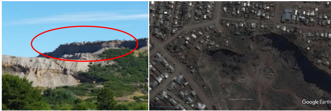
Figura 26 – Viviendas sobre el talud de la Cantera Municipal. Fuente: propia, Google Earth [01/10/16].
