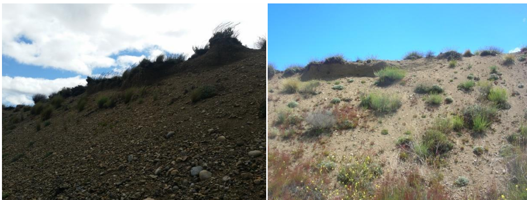
Figura 38– Erosión eólica en taludes del Sector 3. Fuente: propia.
