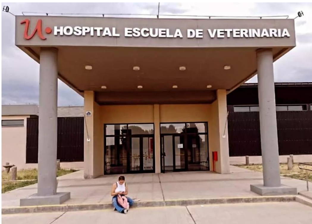
Figura 1. Hospital Escuela de Medicina Veterinaria. Fuente: Propia
