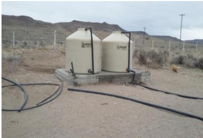
**Figura 14** Tanques reservorios de agua de perforación y agua tratada
