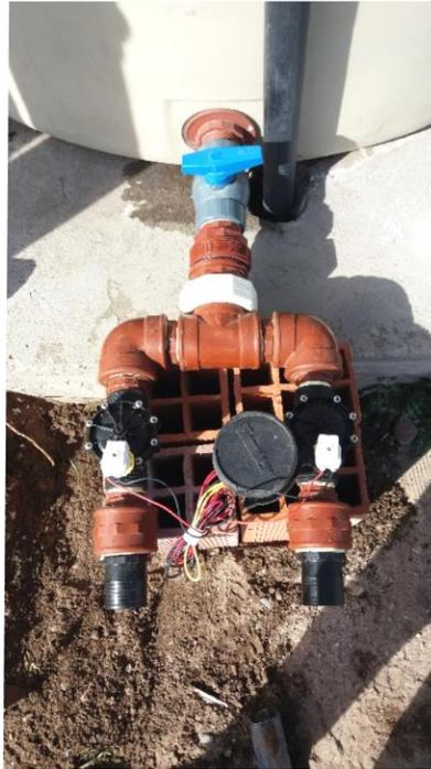
**Figura 15** Automatización con Programador, electroválvulas y solenoides para baja presión
