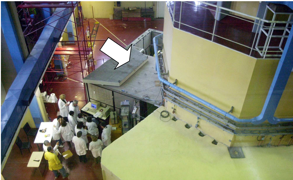
Figura 16: Hall del reactor RA-6 mostrando el equipo de trabajo junto a la nueva sala de irradiación (bloques de concreto hacia el centro de la foto, flecha blanca) alrededor de la salida del conducto que contiene la facilidad de BNCT. Fuente: Gentileza Ing. Carlos Fernández.
