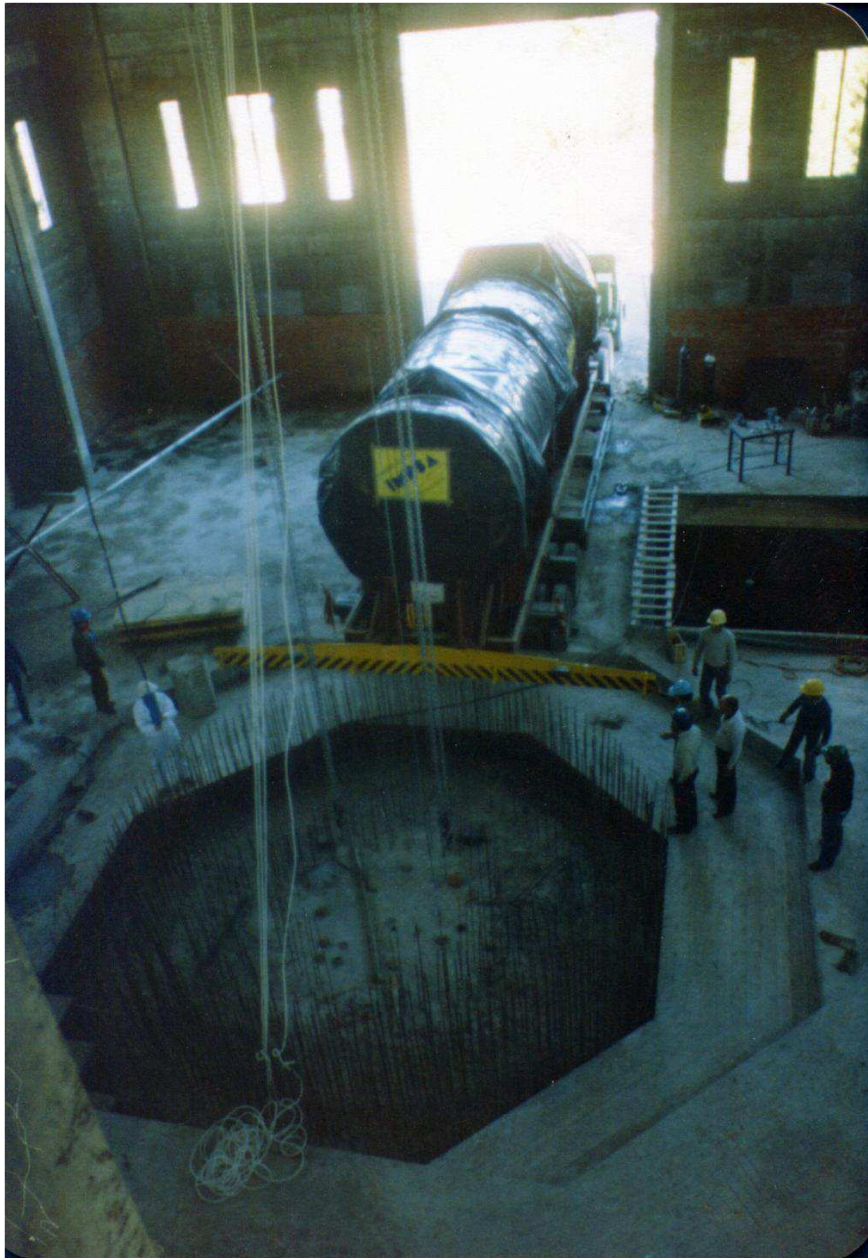
Figura 4: Introducción al hall del reactor del tanque de acero inoxidable que oficiará de pileta del reactor nuclear experimental RA-6. Fuente: Gentileza Ing. Carlos Fernández.
