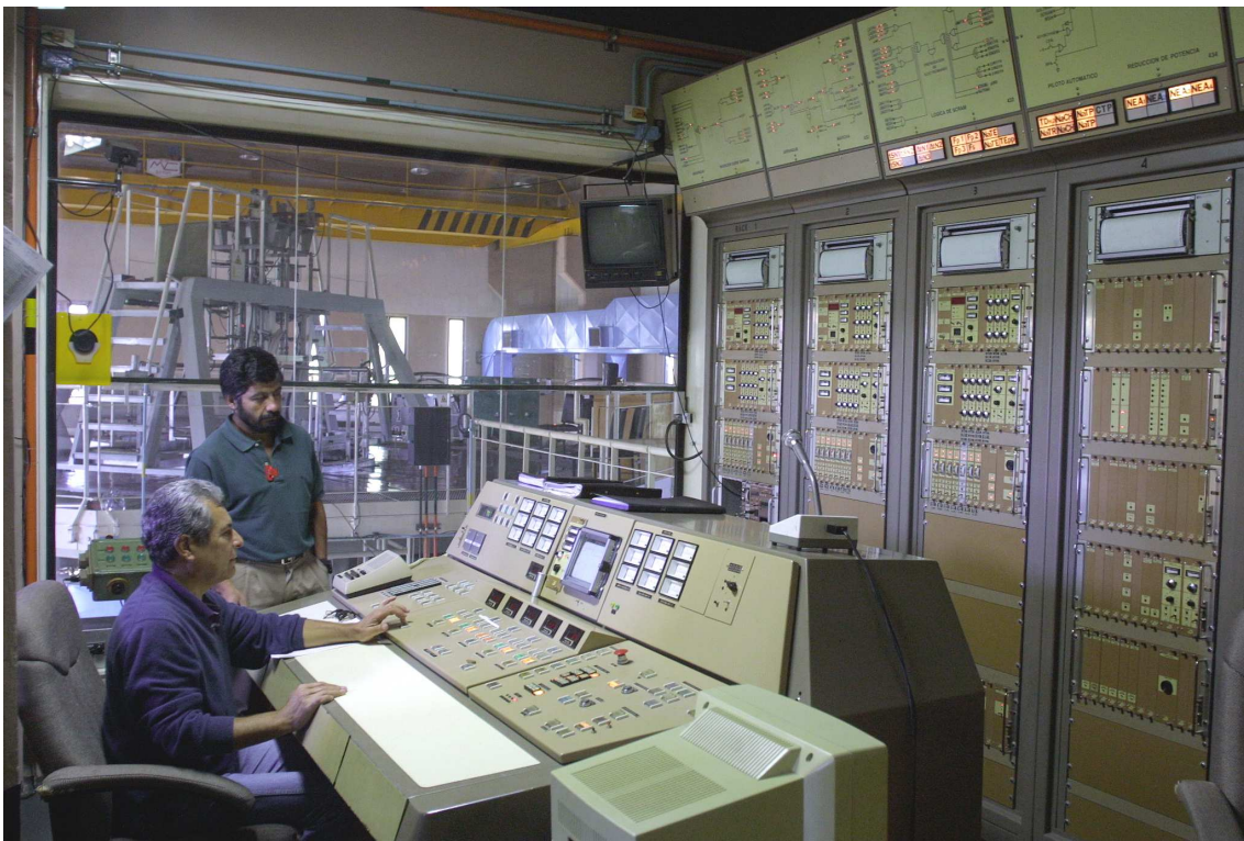
Figura 13: consola de operación. Posee una ventana vidriada que permite observar el hall del reactor. Las señales se adquieren y muestran con triple redundancia. Fuente: Gentileza Ing. Carlos Fernández.
