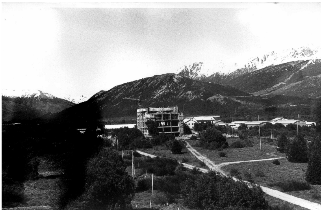
Figura 2: Obra del edificio del reactor nuclear experimental RA-6 en el predio del Centro Atómico Bariloche. Fuente: Gentileza Ing. Carlos Fernández.
